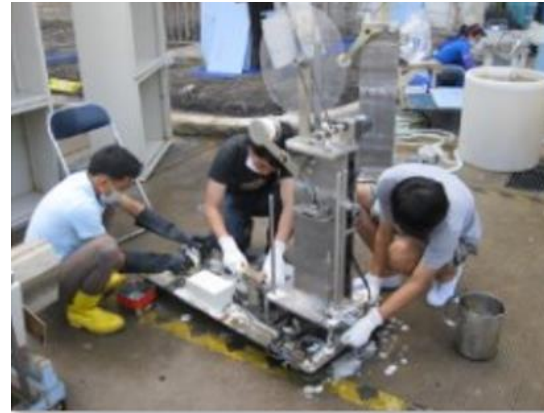
7.水が引いた後の浸水設備のクリーニングと復旧
