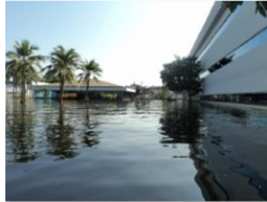
3.対策の甲斐なく敷地内に浸水
