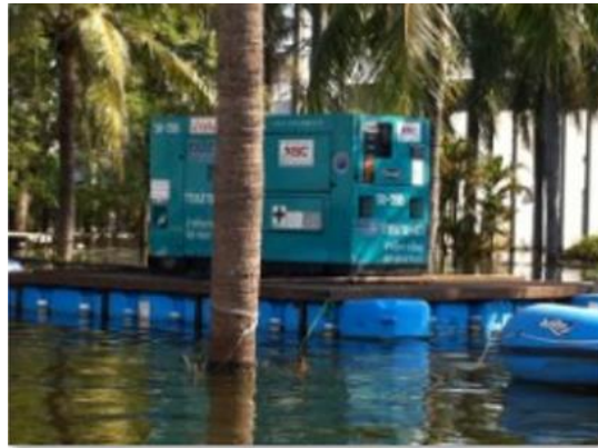
6.浸水箇所以外の稼働再開に向けたインフラ設備の仮設工事
