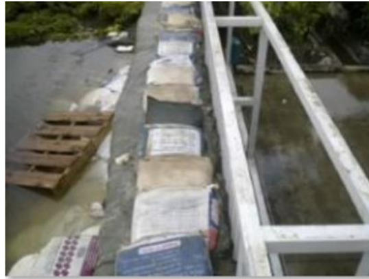
2.敷地外周への土のう積上げ
